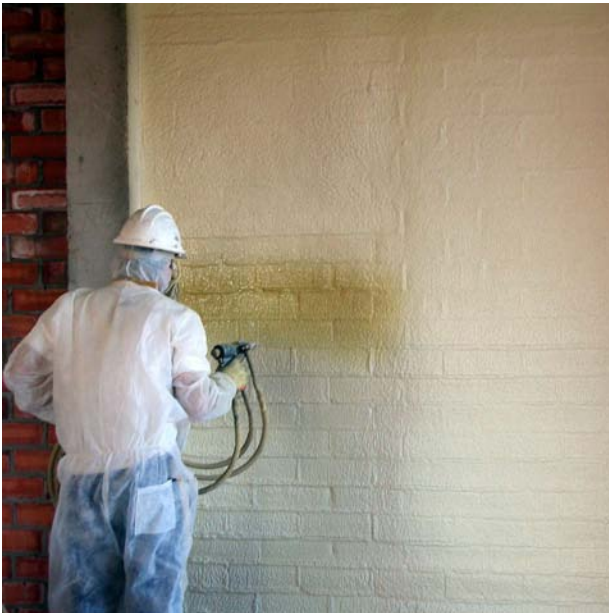
Proceso de proyección de poliuretano
